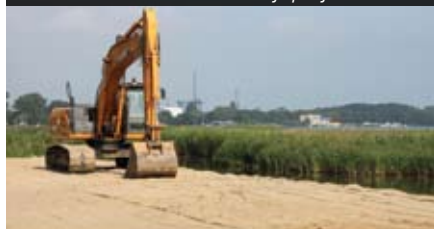
Stacja w trakcie realizacji projektu
