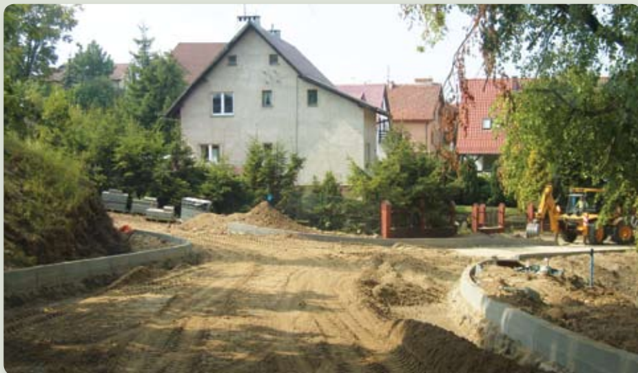
Budowa ulicy Plażowej w Straszynie zostanie zakończona w tym roku
