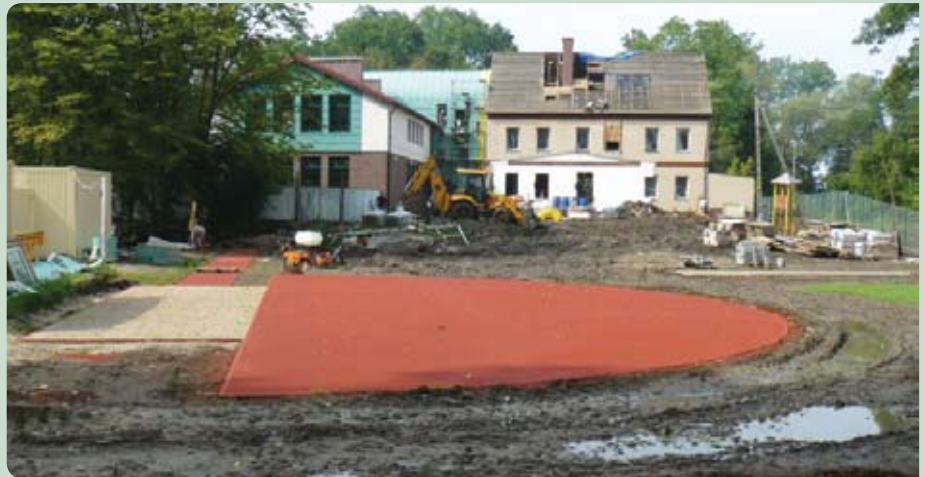
Trwa modernizacja Szkoły Podstawowej w Wiślinie
