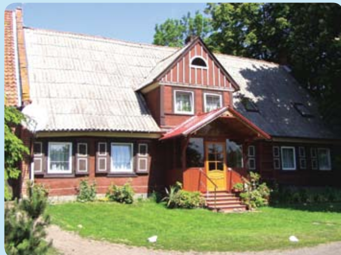
Na terenie gminy Pruszcz Gdański jest jeszcze wiele obiektów pokrytych azbestem
