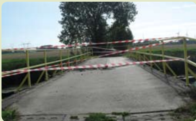
Nie wiadomo kiedy most będzie przejezdny
