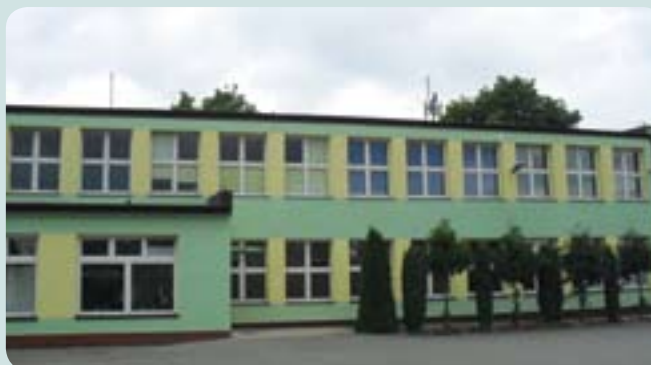
W Przejazdowie prócz wykonania termomodernizacji, dobudowano szatnię dla uczniów
