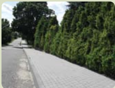
Chodnik w ciągu ul. Długiej w Łęgowie jest gotowy
