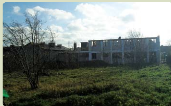
Budowa szkoły w Borkowie
