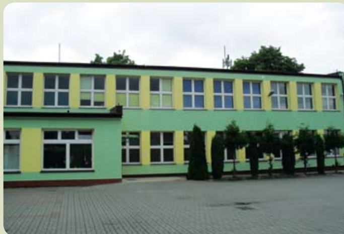
Przeprowadzono prace termomodernizacyjne szkół w Wojanowie, Przejazdowie i Łęgowie. Prace polegały na ociepleniu dachów i ewakuacji oraz na wymianie stolarki okiennej.
