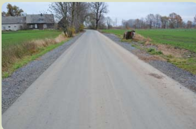
Przebudowano ulicę Jesionową w Przejazdowie. Koszt inwestycji to 146 009 zł.
