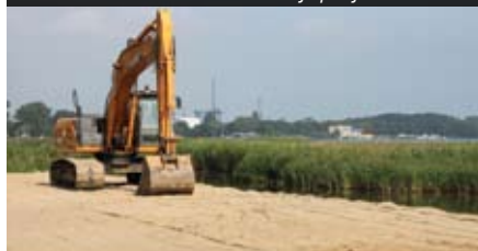
Stacja w trakcie realizacji projektu
