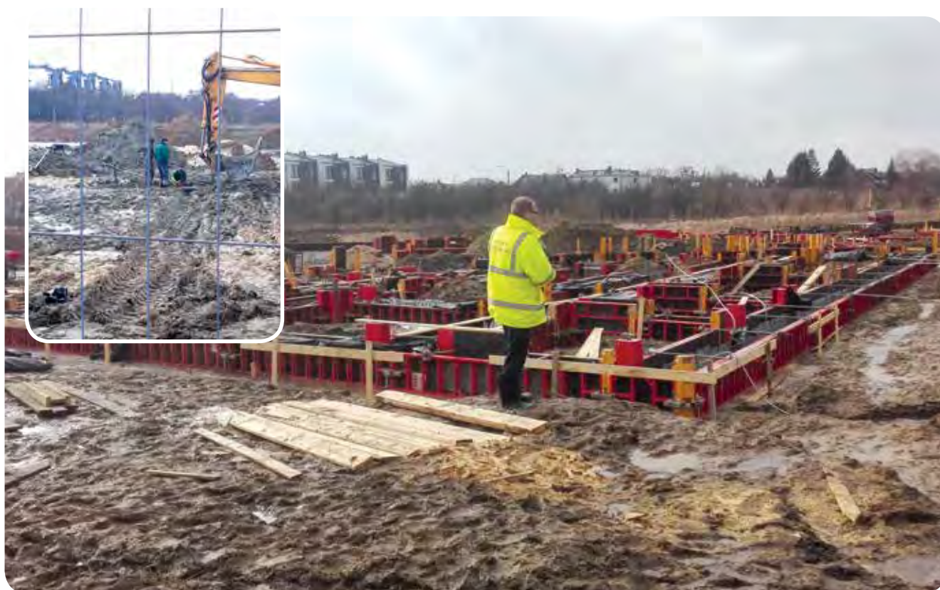
Oddanie nowego budynku do eksploatacji nastąpi w kwietniu 2019 roku
