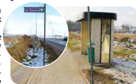
Trakt wraz z oświetleniem i kanalizacją sanitarną ciągnąć się będzie od przystanku autobusowego przy rondzie w Wojanowie do skrzyżowania DW 226 z ulicą Żurawią w Jagatowie
