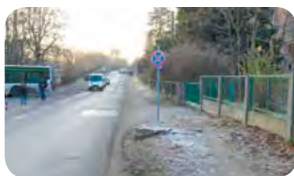
W ramach budowy węzła integracyjnego w Ciepłowie zmodernizowana zostanie ulica Macieja Rataja w Rusocinie
