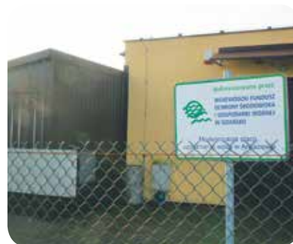
Rozbudowane zostało m.in. ujęcie wody w Arciszewie
